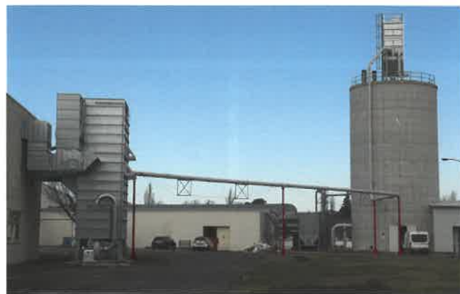
>Oben: Die Fertigungsline wird über ein Flächenlager „TLF 411“* versorgt, in dem über 5.000 Platten Platz finden. Mitte: Die konsequente Digitalisierung ermöglicht, dass sich innerhalb der Anlage jedes einzelne Werkstück in Echtzeit am Bildschirm verfolgen lässt. Unten: Auch die Absauganlage ist komplett neu, Hersteller ist Scheuch Ligno.
