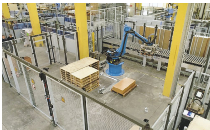
Der Roboter schleust hinter dem Sortierer und vor der Bohr-, Dübeleintreib- und Frässtation Teile in die Linie ein oder aus
